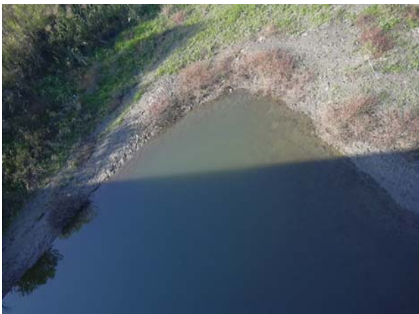
御幸橋橋脚部分のたまり。
